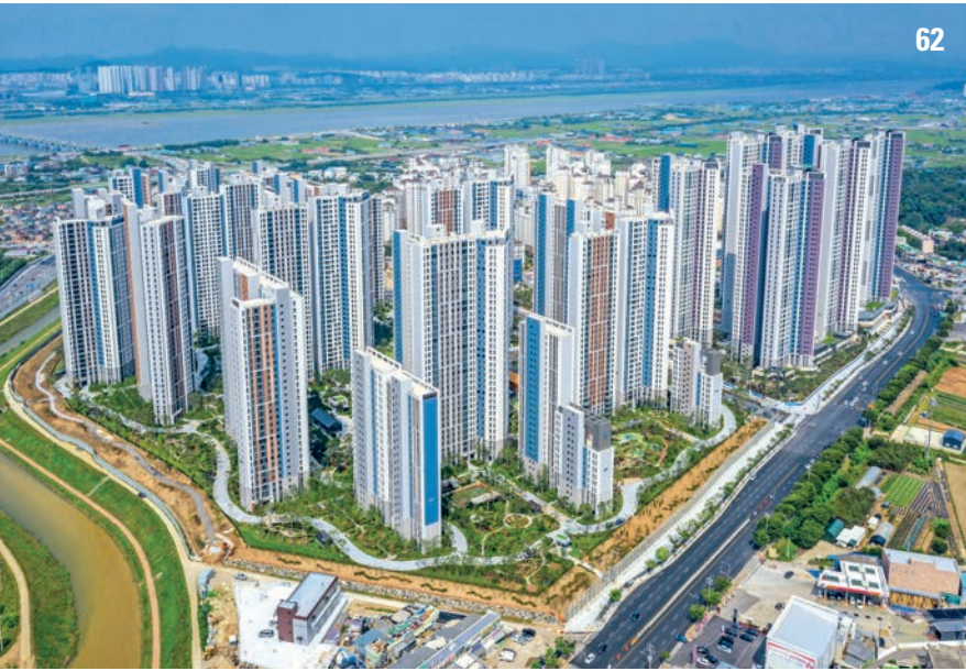
62. 한강메트로자이 경기도 김포시 결포동 - 총 4,029세대 - 1단지 1,142세대 - 2단지 2,456세대 - 3단지 431세대 공사기간: 2017. 05 ~ 2020. 08
