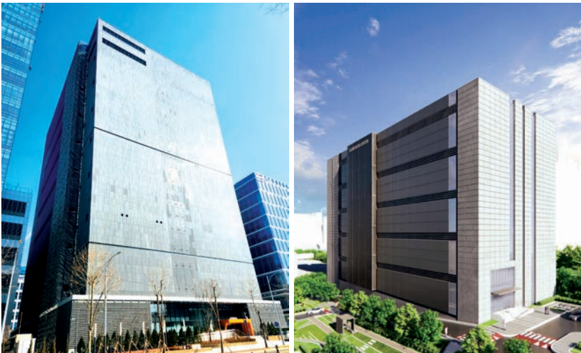
안양 EPOCH 데이터센터 40MW (’24년 1월 준공) 일산 덕이동 20MW (착공)
