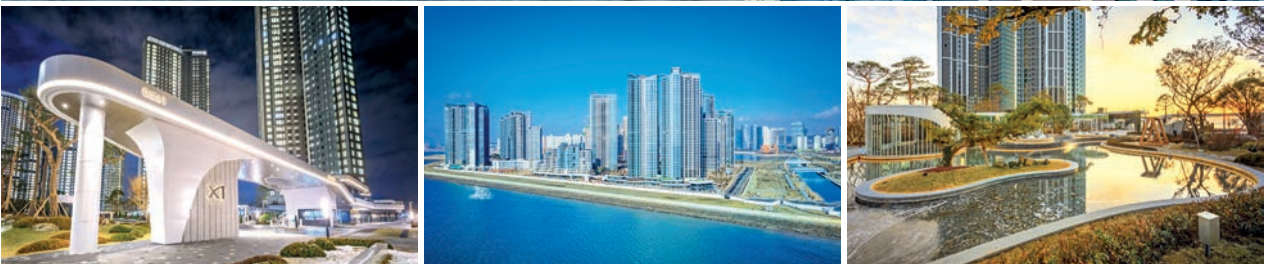
51. 송도자이 더 스타 위치: 인천광역시 연수구 - 1,533세대 공사기간: 2021. 10 ~ 2024. 12
